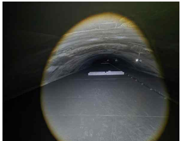
신월여의지하도로 (여의도방향) 풍도슬래브
