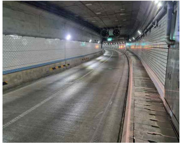
신월여의지하도로 (여의도방향) BOX구간
